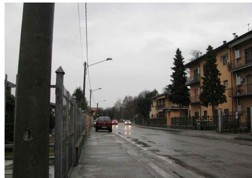
Via San Rocco
