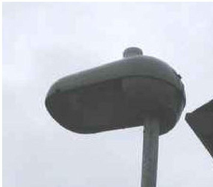
Traversa di Via San Giorgio: armatura stradale totalmente schermata
