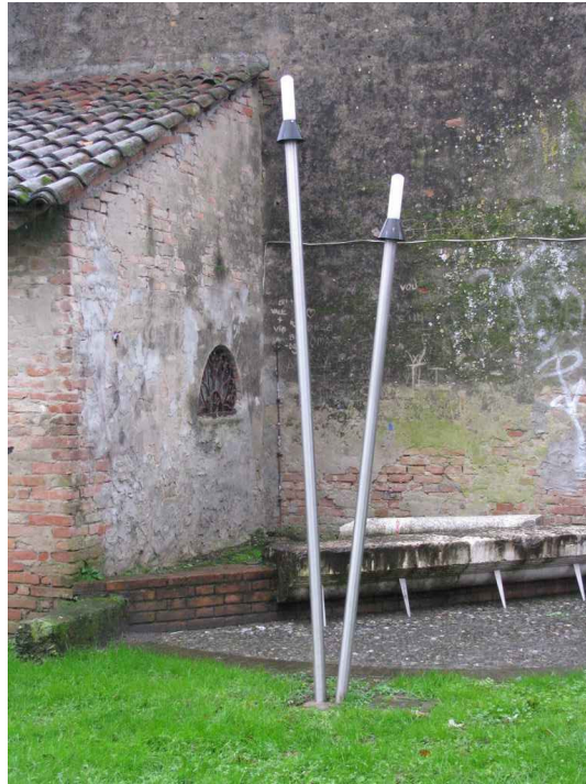
Parco pubblico in Via Mazzolari - apparecchi di arredo urbano diffondenti non compatibili con le leggi regionali vigenti.
