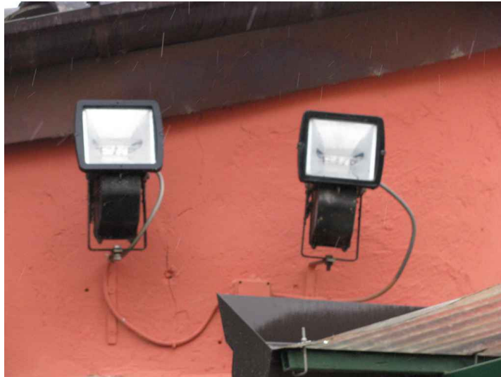
Proiettori per l'illuminazione architettonica d'accento del municipio (ex Villa Premuli)
