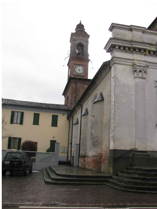
Campanile della chiesa Parrocchiale di San Giorgio: si possono notare i proiettori per l'illuminazione architettonica d'accento dell'orologio.
