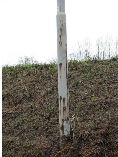
Via San Rocco
