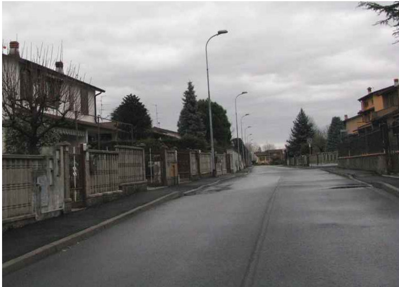
Via Zanelli: apparecchi stradali totalmente schermati installati su palo
