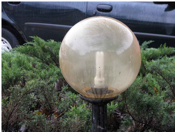
Municipio - globo diffondente non conforme alle leggi regionali vigenti.
