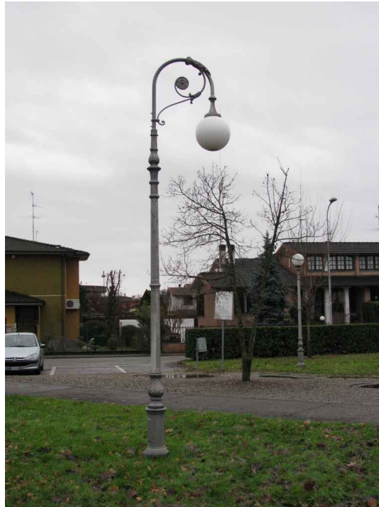
Parco pubblico in via Monsignor Panzetti - apparecchi di arredo urbano tipo globo diffondente non conforme alle leggi regionali vigenti.
