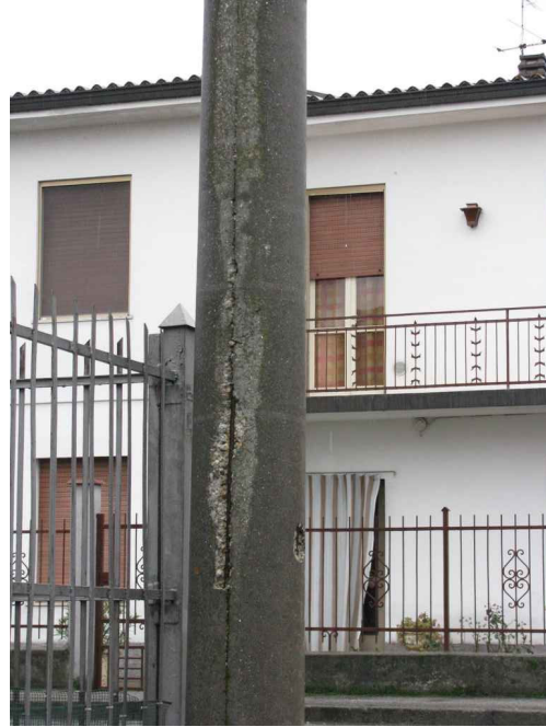
Via San Rocco
