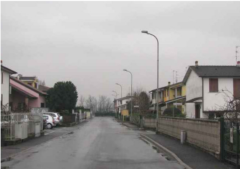
Via Indipendenza: armature stradali totalmente schermate installate su palo
