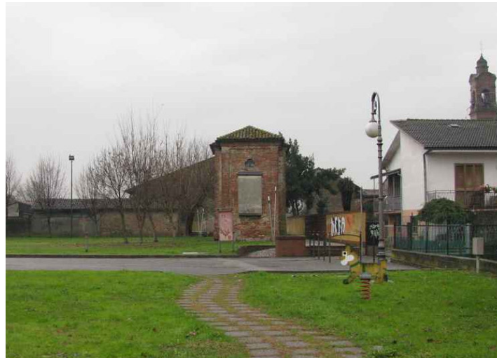
Parco pubblico in Via Mazzolari - apparecchi di arredo urbano diffondenti non compatibili con la L.R. 17/00 e s.m.i.
