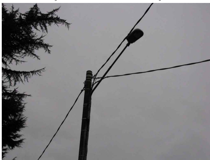
Via San Rocco: giunzione di cavi su palo in c.a.c.
