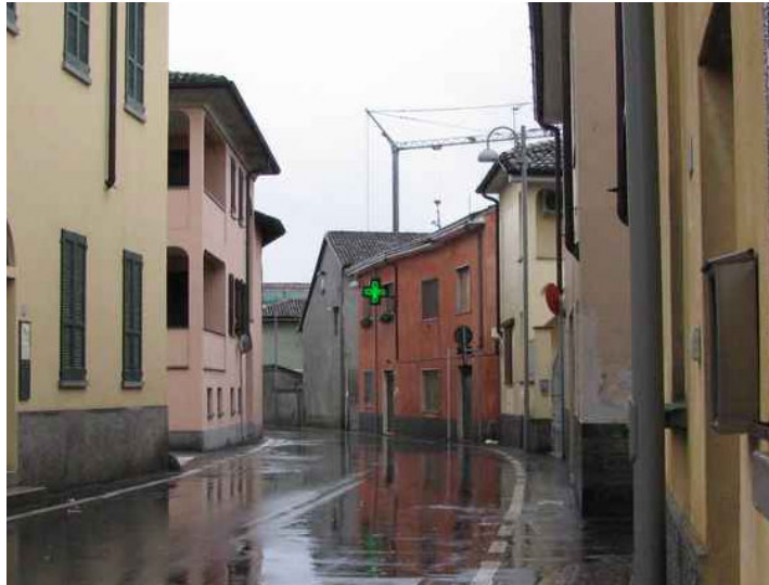
Via San Giorgio - apparecchi di tipo decorativo con ottica stradale dotati di vetro di chiusura piano conforme alle vigenti leggi regionali
