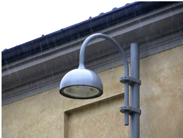
Via San Giorgio: apparecchio decorativo dotato di vetro di chiusura piano conforme alle leggi regionali vigenti
